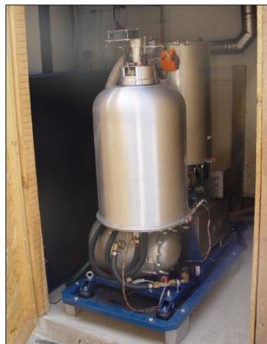
Sunmachine brez pokrova, nameščena v zasebni hiši
